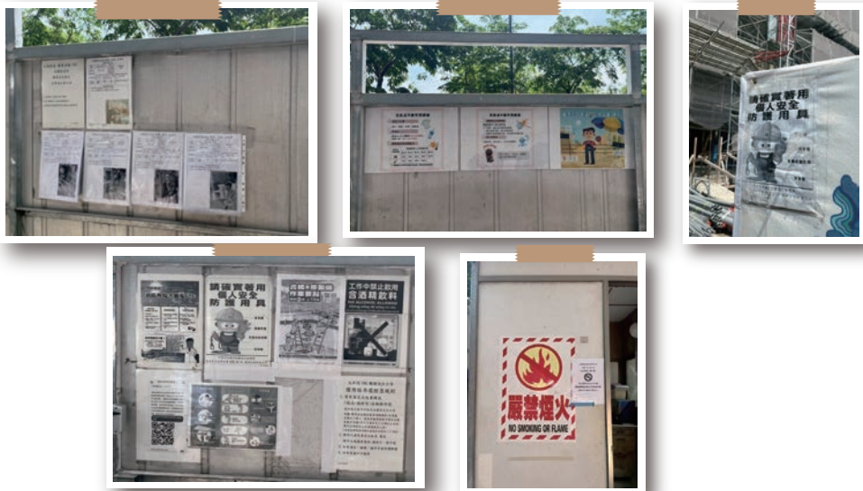
📷 營建基地張貼多元安全標語及警示標示，提醒人員遵守作業規範，落實現場安全管理。
