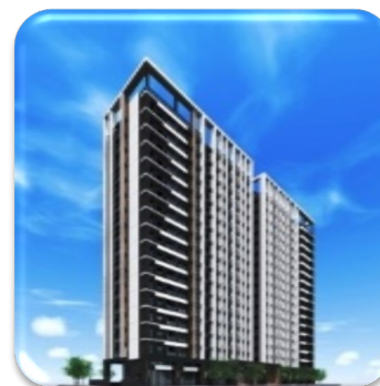
【大城知丘】 預計115年06月完工
